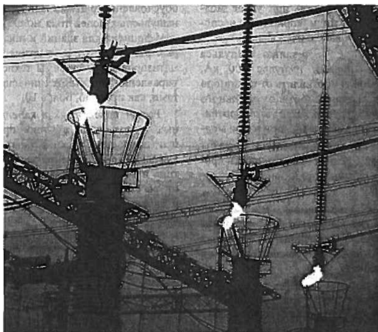
Рис 1.10. Коммутация разъединителем на ОРУ 500 кВ
